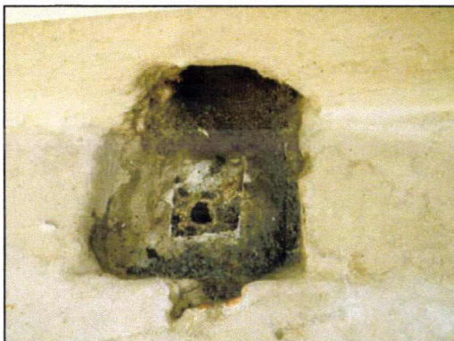
Visuels sur étanchéités des terrasses du 6° étage prélevées ne contenant pas d'amiante.
