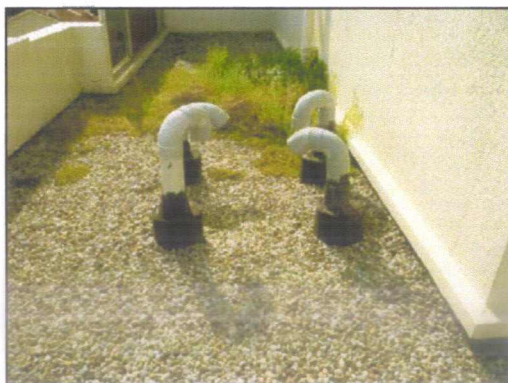
Visuels sur terrasse du 5°étage avec sable et graviers sur étanchéité ne contenant pas d'amiante.
